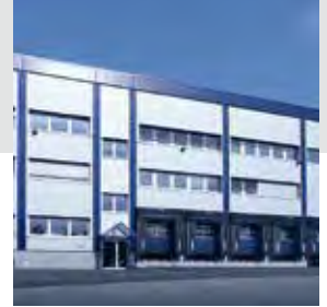
Inbedrijfname van het nieuwe centrale magazijn in 2013
