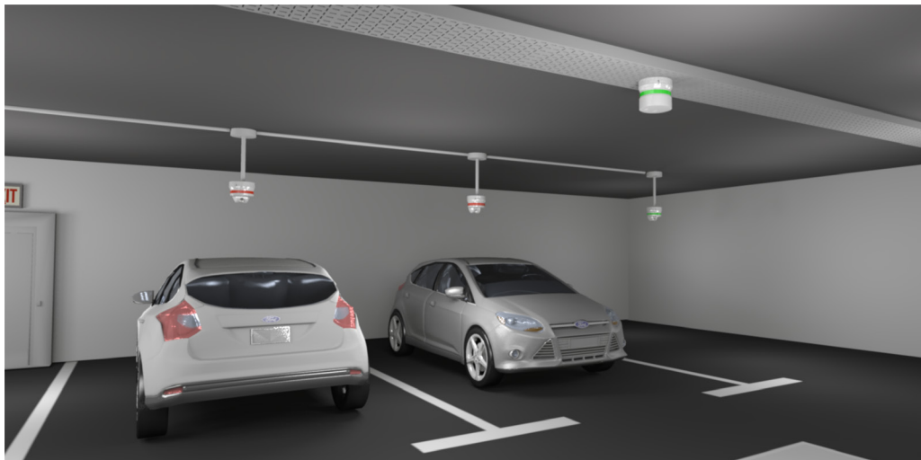
Fig. 5 Ein SBPILED-Indikator ist mit drei SBPSUSL-Sensoren verbunden
