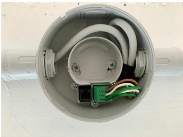
为避免电缆绝缘受到损坏，请将导线盘绕放在支座内件中。
