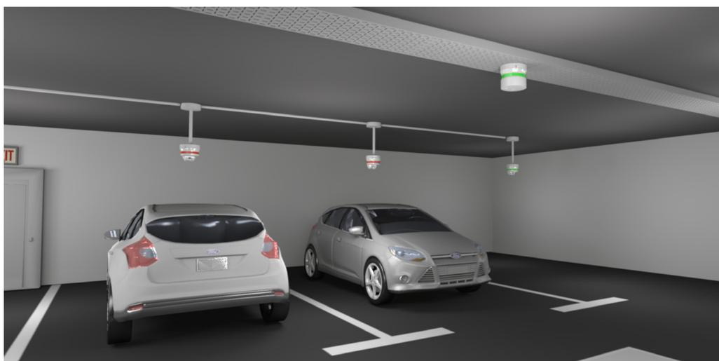
**Fig. 5** Un indicateur SBIPILED associé à trois capteurs SBPSUSL
