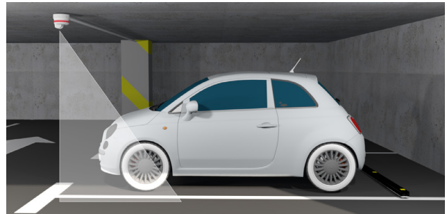
Radstopper vermeiden es, zu weit vom Sensor entfernt zu parken
